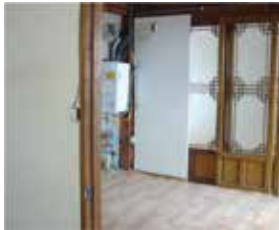
변경 전 : 계단실 설치 전 보일러 설치하여 사용
