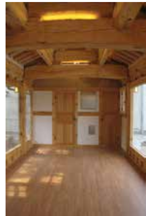
대들보 상부 조명 설치
