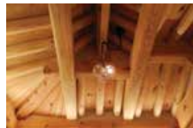
개판마감 시공사례 (개판마감 공사순서 p116 지붕공사과정 참조)
