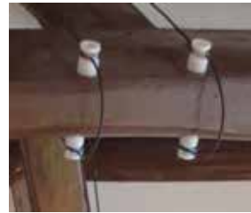
애자 전기 배선 설치 : 전선 중간 중간에 기둥 역할을 해주듯 전선 등을 지지하는데 쓰이는 절연물
