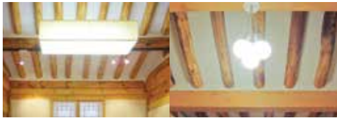
치발이 마감 공사 후
