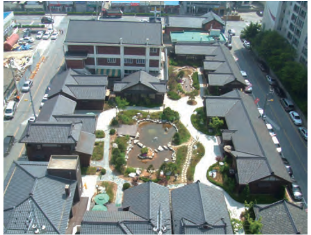
우선정비권역 중 월명성당권역의 정비 전·후
