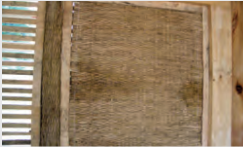
짚 단열재 시공
