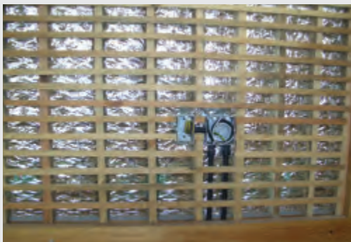
열반사 단열재 시공
