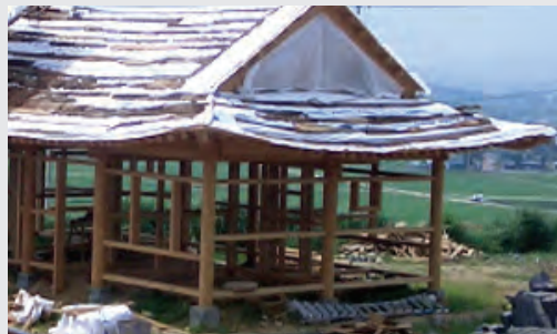
왕겨 충진 및 방습포 시공
