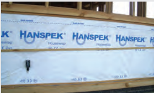
방습포 설치 중 (내부 왕겨충진)
