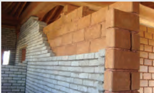
시멘트 벽돌과 황토블록 시공
