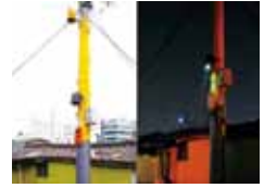
블랙박스 CCTV, 고보조명설치
