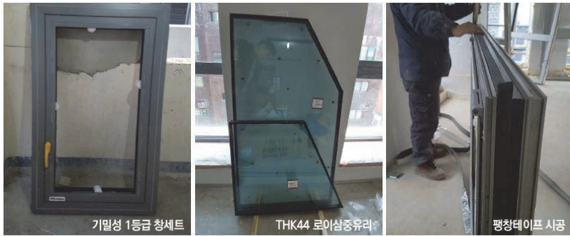
[그림 3-8] 패시브 창호 시공
