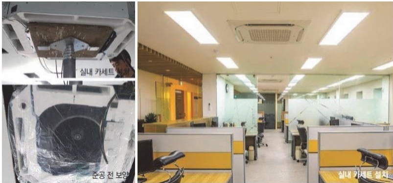
[그림 3-11] 고효율 EHP 공사(인체감지센서 설치)
