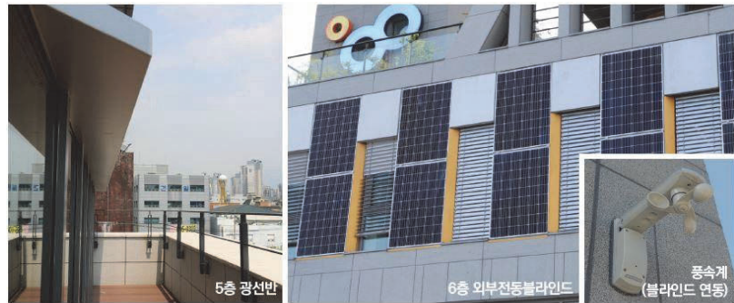
[그림 3-7] 광선반(좌) 및 외부전동블라인드(우)
