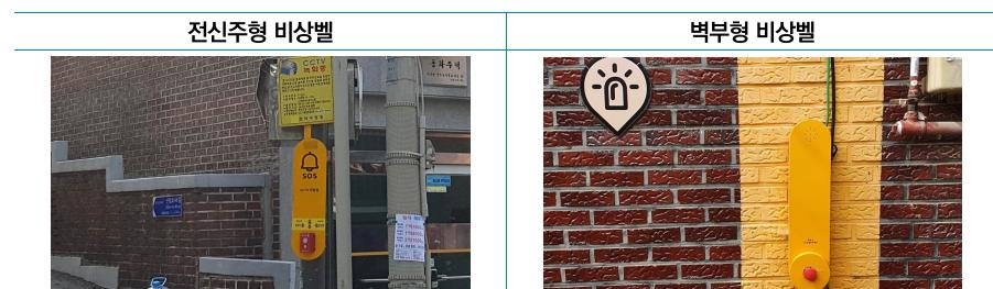
[그림 2-7] 비상벨 설치 사례
