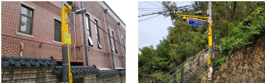
[그림 2-2] 가로용 방법 카메라 설치 사례
