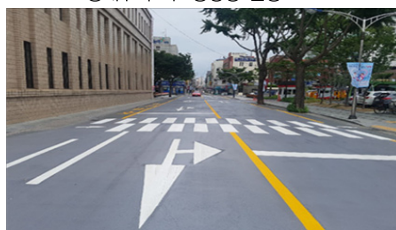
차열성포장 시공(시청앞 도로)
