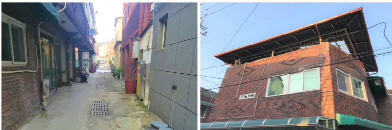
[그림 3-19] 세종시 부강면의 배수 인프라(좌)와 슬래브형 건축물의 덧댄 지붕 현황(우)
