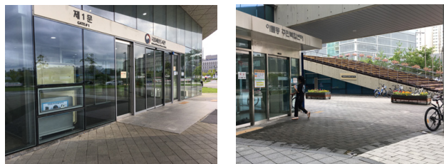
[그림 3-8] 단차가 없는 건물 출입구(좌: 국립세종도서관, 우: 아름동 복합커뮤니티센터) 출처: 연구진 직접 촬영
