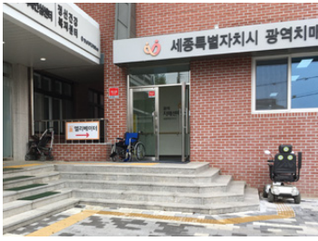
건물전면 휠체어 보관장소 부재
