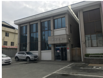
보행공간이 구분되어 있지 않은 건물 전면공간
