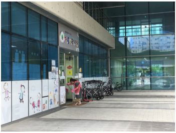
출입구 전면 유모차 및 자전거 보관 장소 부재
