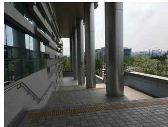
활용도가 낮은 건물 상층부로 연결된 외부계단
