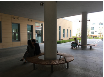
어두운 건물 출입구 부분
