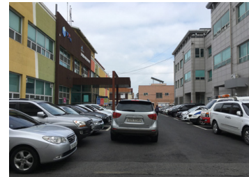
주차로 인해 적극적인 연결이 어려운 건물 사이 공간
