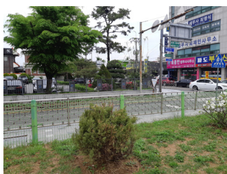
철제 울타리가 설치된 대지 경계부
