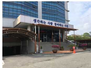
보행로가 단절된 건물 주출입구-학습관
