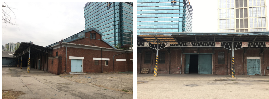
[그림 2-5] 서울시 우수건축자산 2호 영등포구 문래동 대선제분 공장부지 출처 : 저자 촬영
