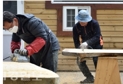
할배목공소 시설 보수 활동 전경
