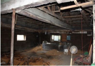
[그림 2-18] 내벽 철거 후 서비스 공간 조성 출처: 전은경 대표 직접촬영 (©전은경)
