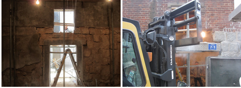
[그림 2-40] 얼음창고 출입구 시공모습
