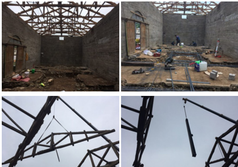
[그림 2-9] 대정창고의 시공 중인 모습
