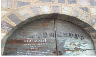
[그림 2-15] 리모델링 후 시문창고의 입구 출처: 연구진 직접촬영 (2018.7.26.)
