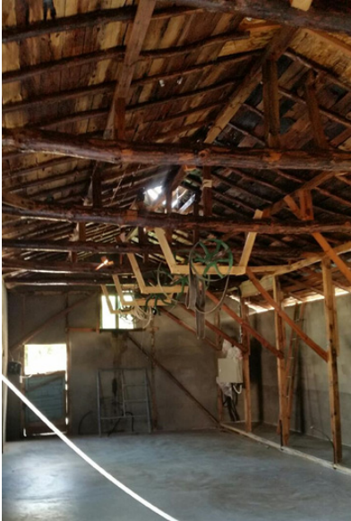
[그림 2-30] 시공 중 초당정미소의 내부모습
