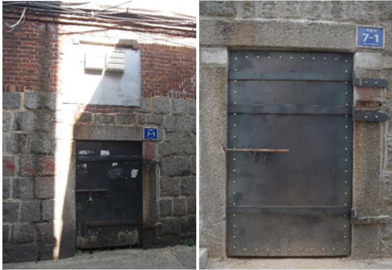
[그림 2-41] 얼음창고 리모델링 전과 후의 출입문
