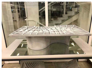
3D 프린팅으로 제작된 콘크리트 슬래브와 벽체(목업) (NEST 빌딩에 실제 적용)
