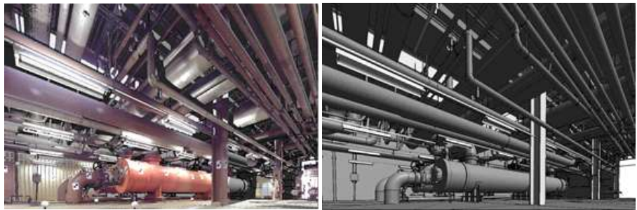
[그림 3-26] 미주리 발전소 연료 파이프의 3D 스캐닝 및 모델링
