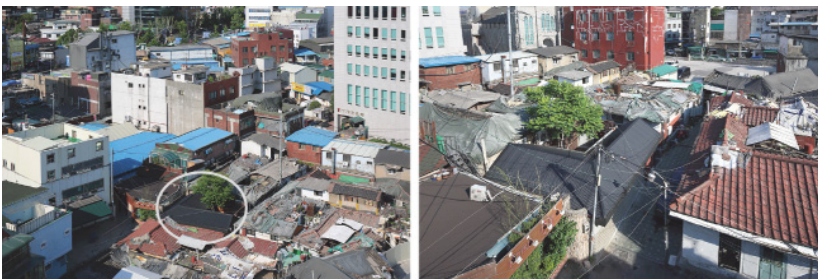
[그림 2-16] 수선을 통해 검정색의 잔골형 컬러강판으로 씌워진 창신기지 지붕
