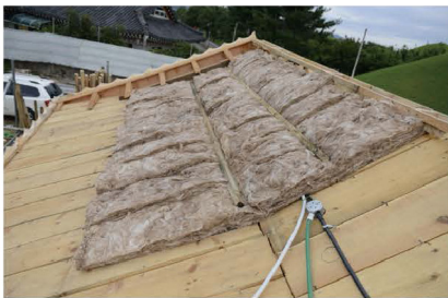
③ 개판 위 단열재설치
