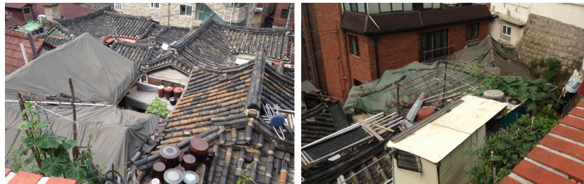
[그림 3-7] 지붕 누수에 대응하기 위해 천막을 씌운 한옥의 모습
