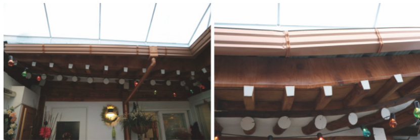
[그림 2-8] 양곡이 드러나는 기존 지붕 처마의 입면을 살린 모습
