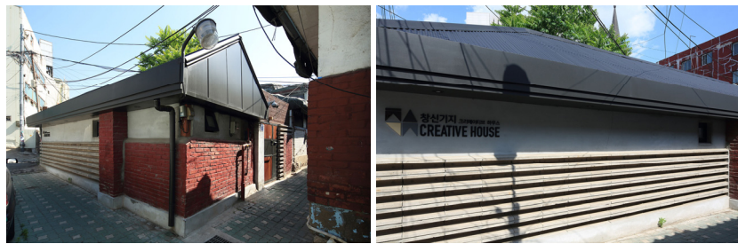
[그림 2-17] 주변과 자연스럽게 어우러지도록 단순화한 지붕마루 및 처마부위 디테일
