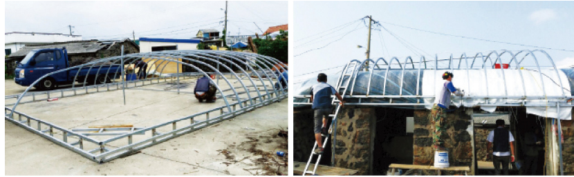
[그림 2-19] 초가지붕과 유사한 형태의 아연도 각관 지붕틀 작업 과정
