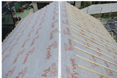
⑨ 방수시트 위 기와걸이용 각재 설치
