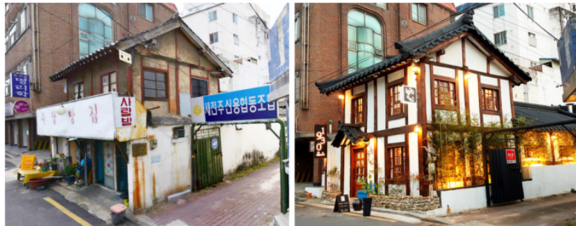
[그림 2-15] 경량신소재기와로 리모델링하여 뚜렷해진 1930가맥 지붕의 형상
