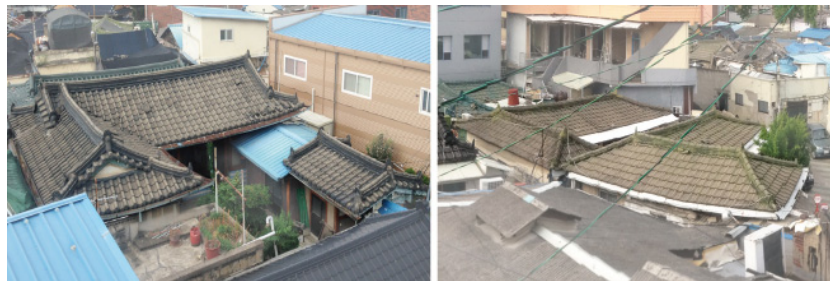
[그림 2-2] 한옥에 시멘트기와 및 일식시멘트기와를 사용한 예 (좌)한식 시멘트기와 사용 예, (우)일식 시멘트기와 사용 예 출처: 연구자 직접 촬영(2017.7.10.)
