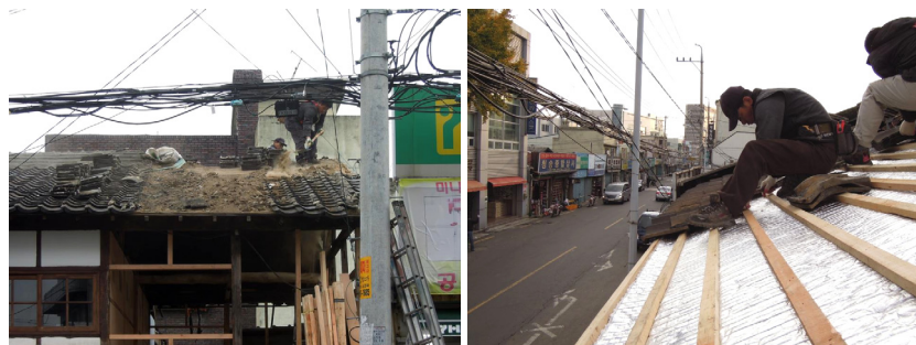
[그림 2-12] 오피스아키텍톤 사무소의 지붕 수선 과정
