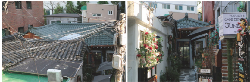
[그림 2-7] 짙은 녹색의 S형 컬러강판이 적용된 수선 후의 지붕
