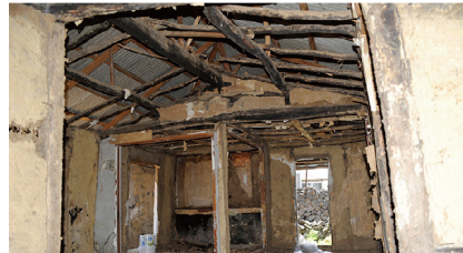
1. 기존 천정 마감 철거
