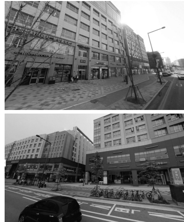
가로벽 구간 조성 현황
