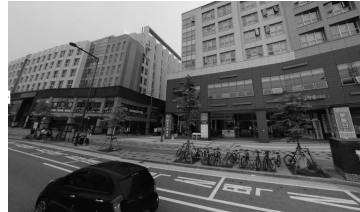
가로벽 구간 조성 현황
