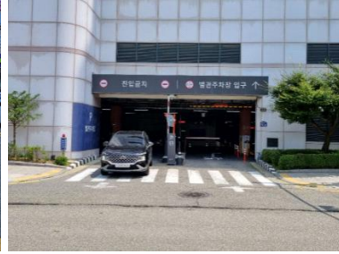
건물주차장입구 - 보도 단절, 횡단보도 설치
