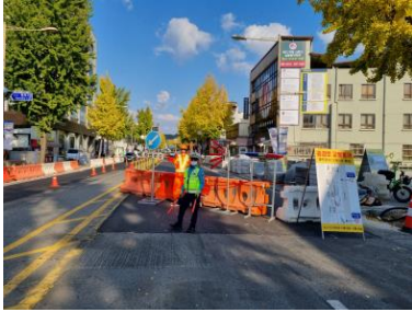
공사중 차량 통제
