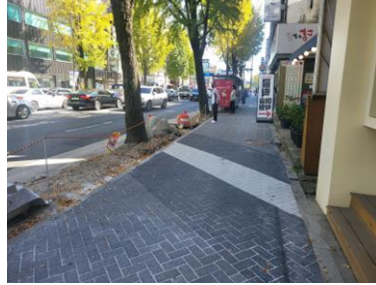
보행영역 통합디자인 시공
