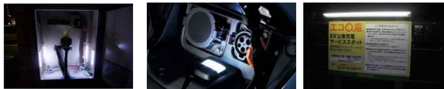
[그림 3-10] EV 충전 공간 조명시설 설치 예
