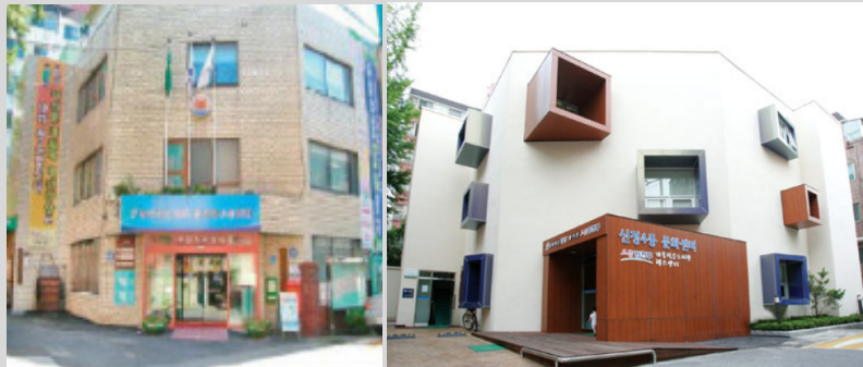
[그림 2-11] 구 신정5동 주민센터 리모델링 전(좌), 후(우)
