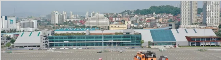
[그림 2-10] 상상플랫폼 리모델링 후
