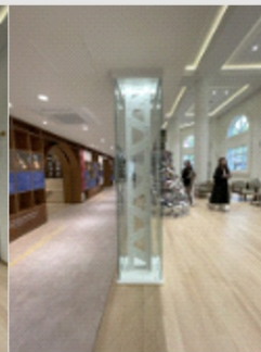
미국문화원 당시 2층 슬래브 증축을 위해 설치된 철골 기둥
