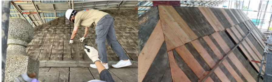
[그림 4-22] 교체부재 선정 및 개판 조립
