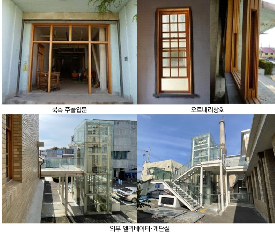
[그림 4-16] 창호 복원 및 엘리베이터·계단실 증축공사
