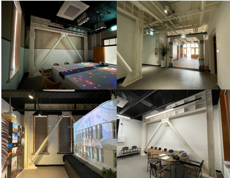
[그림 4-13] 구조보강 공사 완료 후 내부 전경
