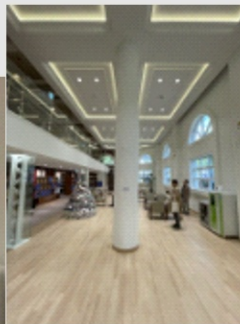
1929년 신축 당시 설치된 철골철근콘크리트 기둥
