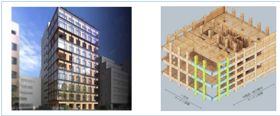
[그림 4-3] Port Plus Building
