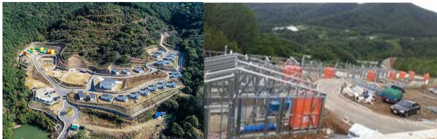
[그림 4-12] 산청 예술인 마을 프로젝트 (우: 지붕 및 벽체 패널과 화장실 및 욕실유닛)
