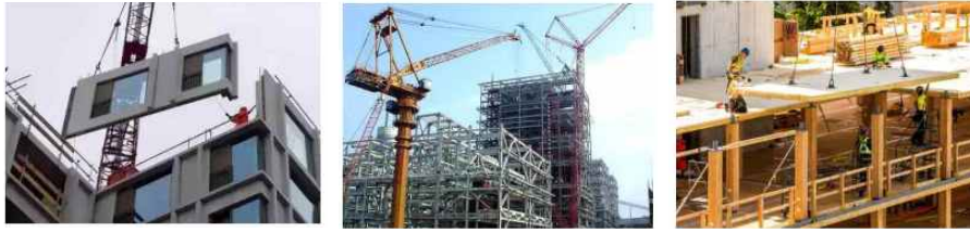
[그림 2-13] 조립식 건축 유형 : 콘크리트구조(左), 철골구조(中), 목구조(右)
