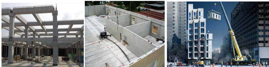
[그림 2-14] 공업화 건축의 주요 공법 : PC 공법(左), 패넬라이징 공법(中), 모듈러 공법(右)
