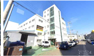
실제 참고건물로 사용 중인 사례(주소:경기도 안산시 상록구 팔곡이동00-00번지, 착공일 2005.3.9.)
