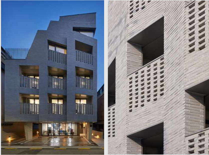
[그림 4-4] 상가주택 반외부 공간 조성 사례 ©노경
