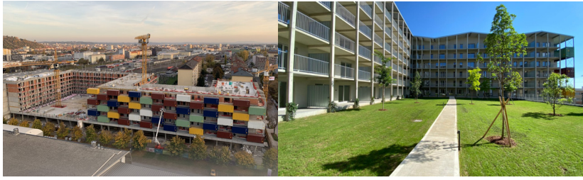
[그림 3-78] My Smart City Graz 공사 및 완료 현장 사진
