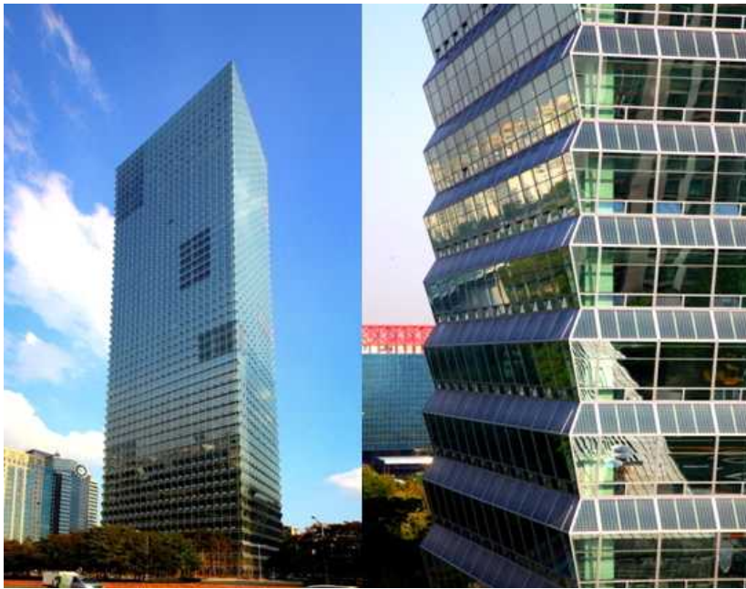
[그림 4-6] 건물일체형 태양광 발전 설비(BIPV, Building Integrated Photovoltaic System)를 적용한 전국경제인연합회 신축 회관
