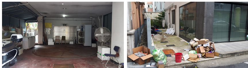
[그림 5-8] 대전광역시 서구 월평1동 대상지의 활용되지 않는 부설주차장 모습
