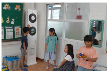
[그림 2-13] 충남 학교에 설치된 스탠드형 공기청정기
