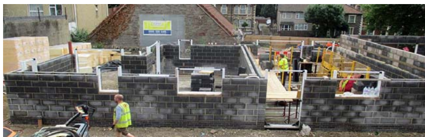
브리스톨 공동체토지신탁의 첫 번째 프로젝트인 피시 폰즈 로드(Fishponds Road) 사업의 건설중 모습
