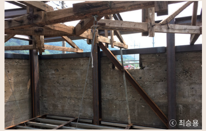
철골보와 기둥을 설치하여 구조보강
