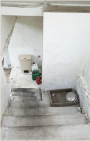
지하1층 창고로 내려가는 계단입구
