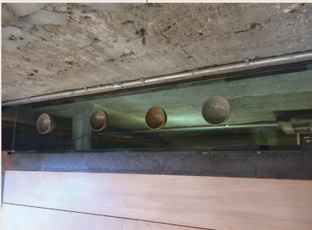
1층 전시공간에 빛이 유입될 수 있도록 2층 바닥 모퉁이를 유리로 시공
