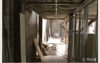
1층 화장실과 작업실 설치를 위한 벽체 작업
