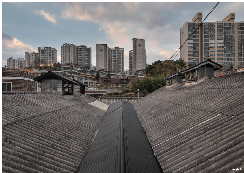
지붕 리모델링 전(상)과 후(하)의 모습
