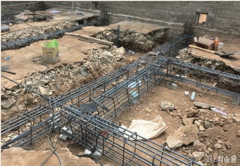
바닥철거 후 보강구조 신설
