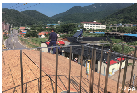
계단실 설치 및 지붕공사
