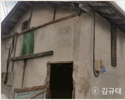
공사 전 초당정미소 주출입구
