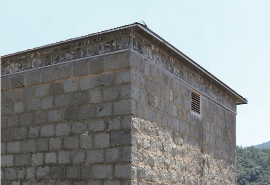
건물의 환기창에 그릴을 설치하고 건축물 내부에서 여단을 수 있는 창문을 덧대어 설치
