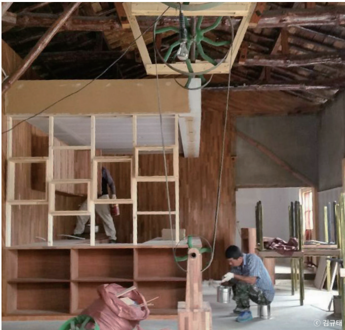
시공 중인 바리스타존의 모습
