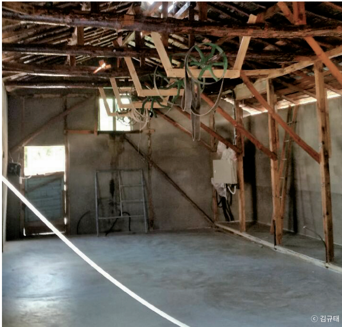
구조부재에 쌓인 먼지제거와 청소, 바닥공사, 구조부재 니스칠 후 초당정미소의 모습
