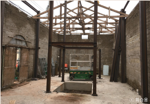
계단실 설치를 위한 목재트러스 부분 철거 및 슬레이트 지붕 철거
