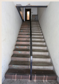
2층 서비스공간으로 올라가는 기존 계단(우)과 포장재를 달리한 계단(좌)
