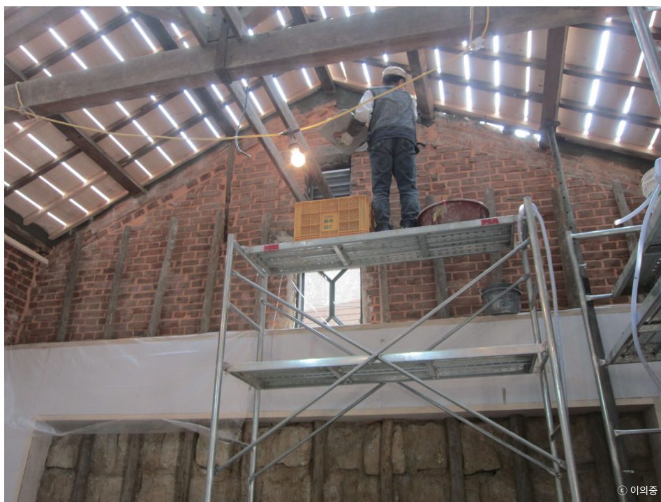
외부와 내부의 벽을 보전하기 위해 줄눈을 털어내고 벌어진 틈을 일일이 메우는 작업
