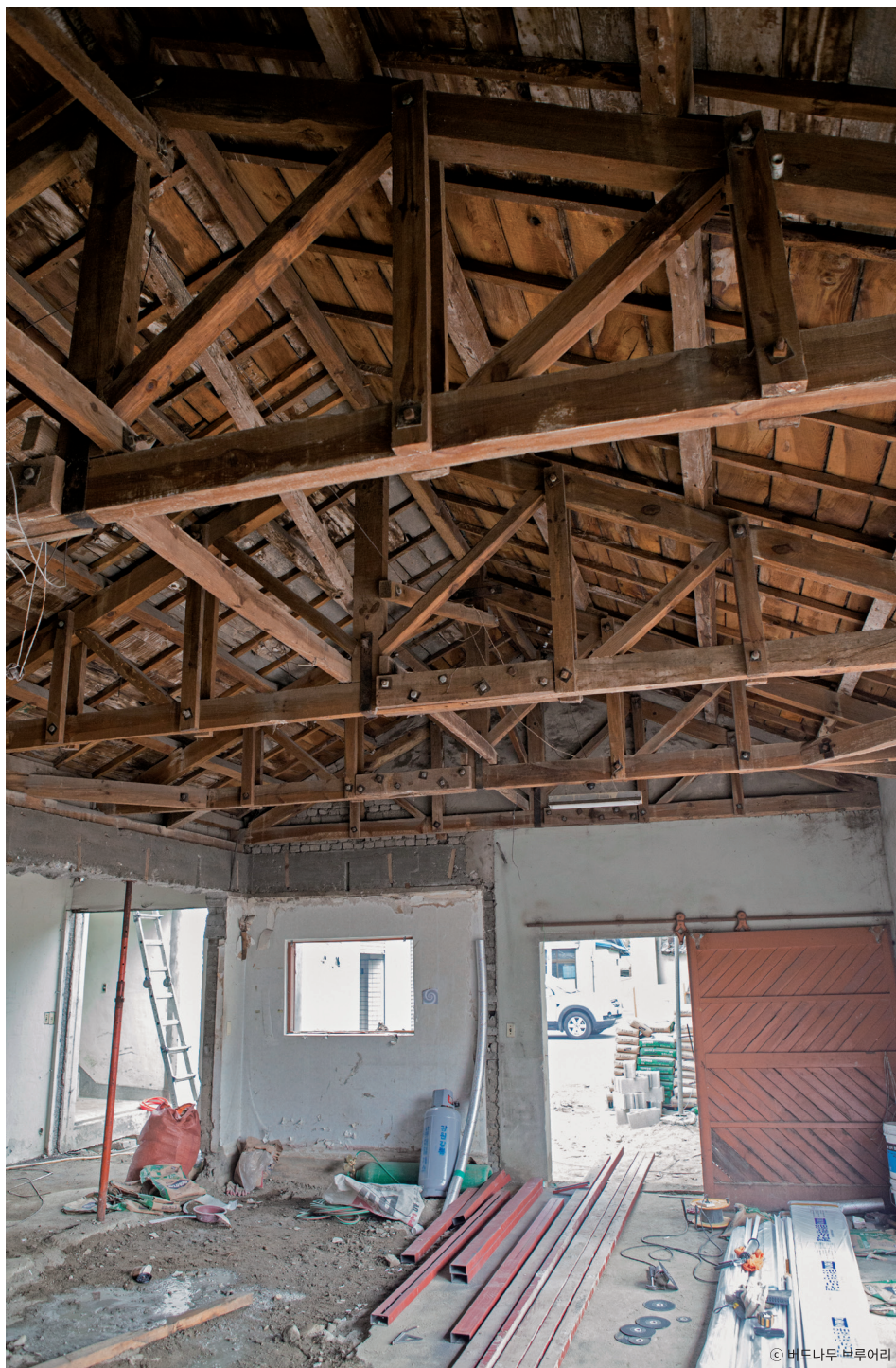
내벽을 헐어 탁 트인 서비스공간을 조성하되, 일부 구조보강을 위해 철재기둥 설치
