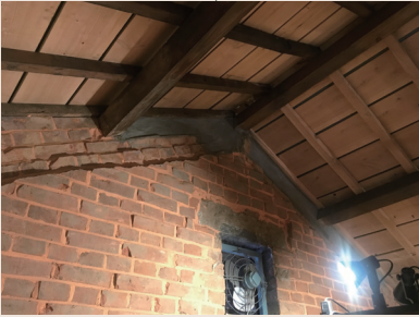
벽과 지붕 사이를 콘크리트로 보강
