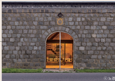
기존 문 철거 후 피벗힌지문 설치
