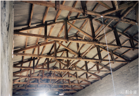
슬레이트 지붕과 목재트러스, 석벽으로 구성된 기존 대정돌창고의 모습
