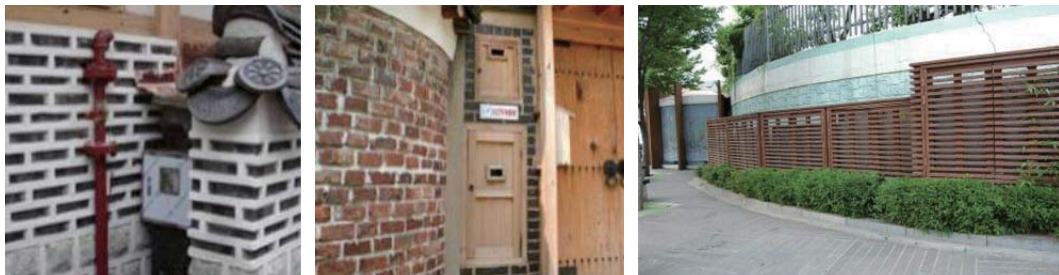
부착시설물 조성 및 차폐 예시
