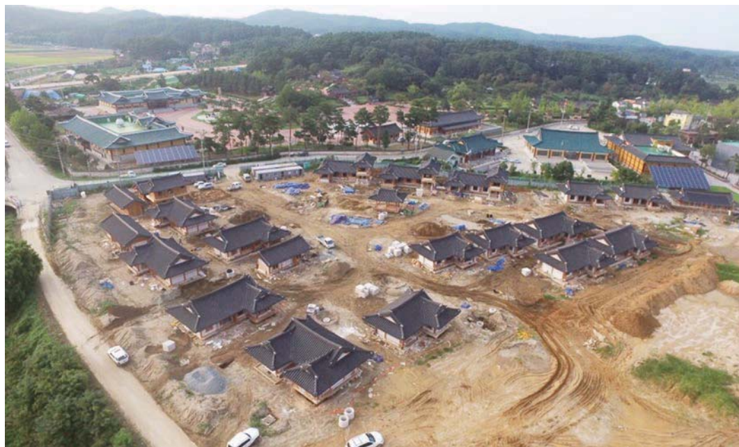
강릉 한옥마을 공사 중 모습
