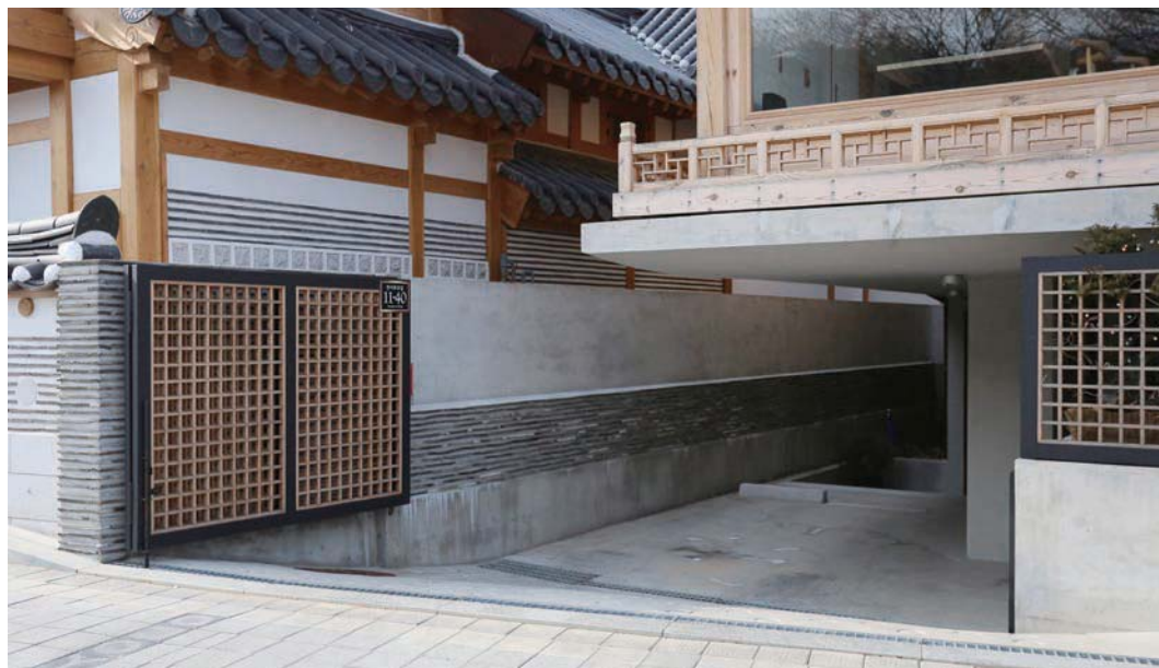
1층 누마루 하부 공간의 주차장
