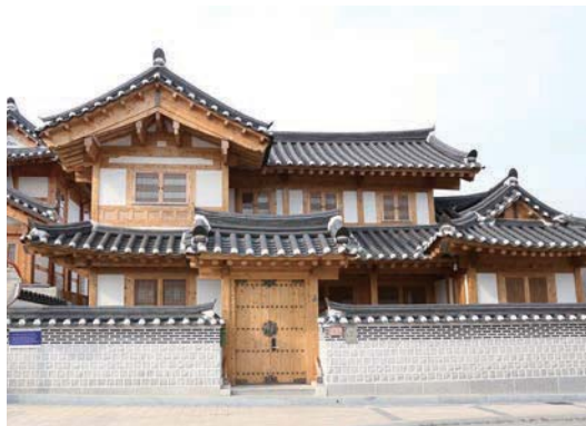
2층 증축 부분의 맞배지붕 박공면
