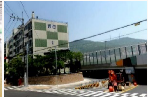
• 폐우암선 교차지점에 위치한 아파트 옹벽
