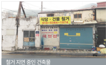
철거 지연 중인 건축물
