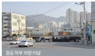
철길 하부 차량 터널
