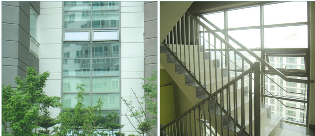
[그림 4-5] 전면 채광창을 통해 외부와의 시선연결이 용이한 계단실
