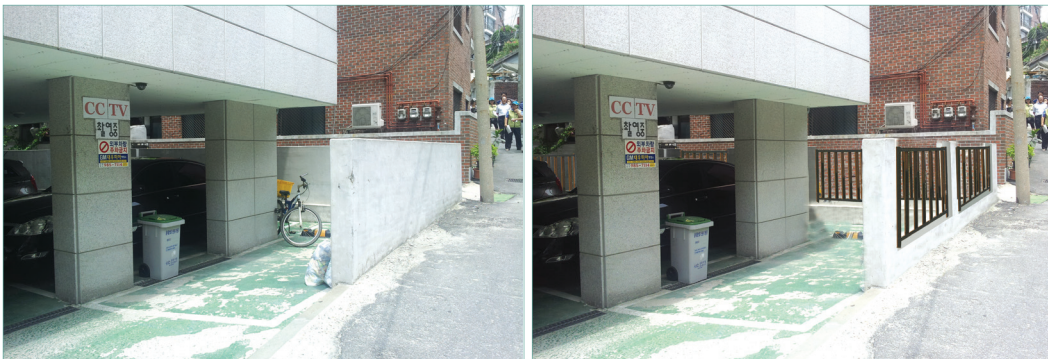
[그림 4-8] 자연감시와 은신공간 제거를 위한 투시형 가벽 설치
