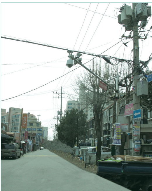
[그림 4-100] 인식이 어려운 CCTV (서울시 2차 범죄예방디자인 시범사업 지역 : 관악구 행운동)
