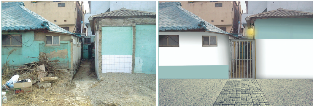
[그림 4-20] 건물사이 공간의 출입통제를 위한 시설 설치
