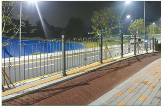
[그림 4-9] 순환형 산책로와 외부 보행공간의 시선연결이 자유로운 단지 경계부
