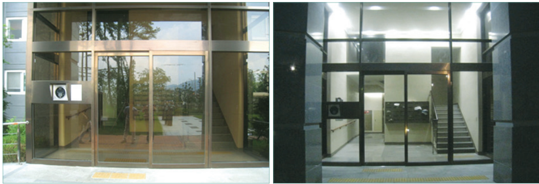
[그림 4-15] 야간에도 내외부 시선연결이 용이한 투시형 구조의 출입구
