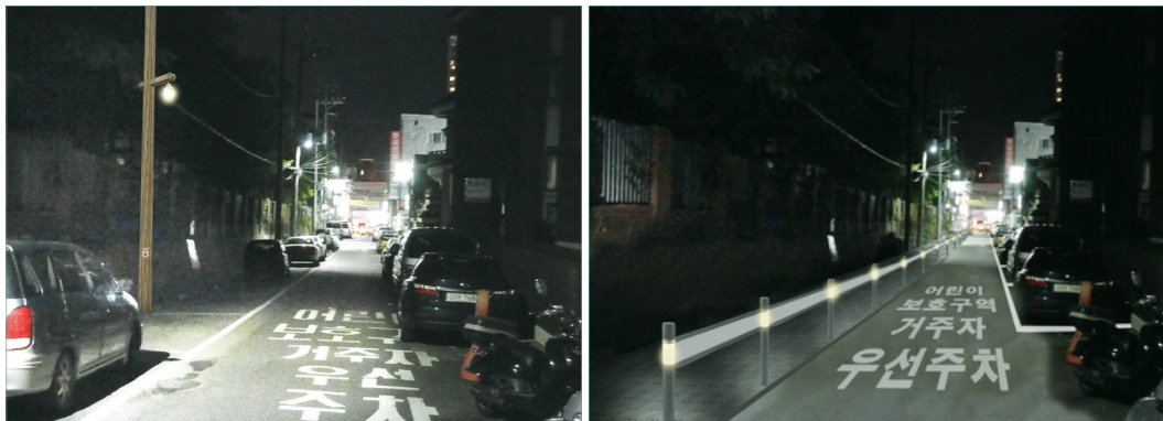
[그림 4-40] 야간 보행자 안전을 고려해 설치된 보호펜스
