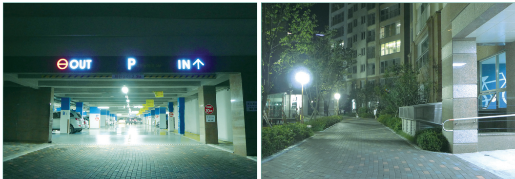
[그림 4-82] 조명을 통해 쉽게 인식되는 지하주차장 출입구
