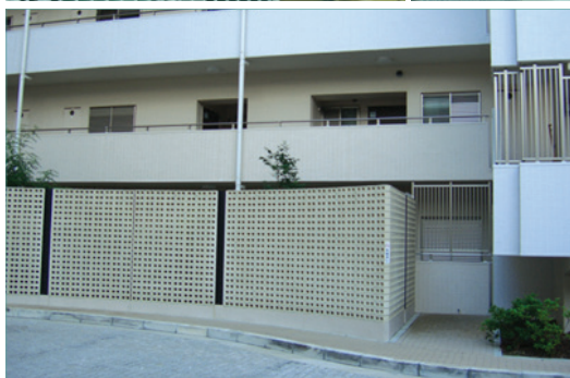
[그림 4-24] 저층세대 침입방지 및 감시를 위한 외부장치
