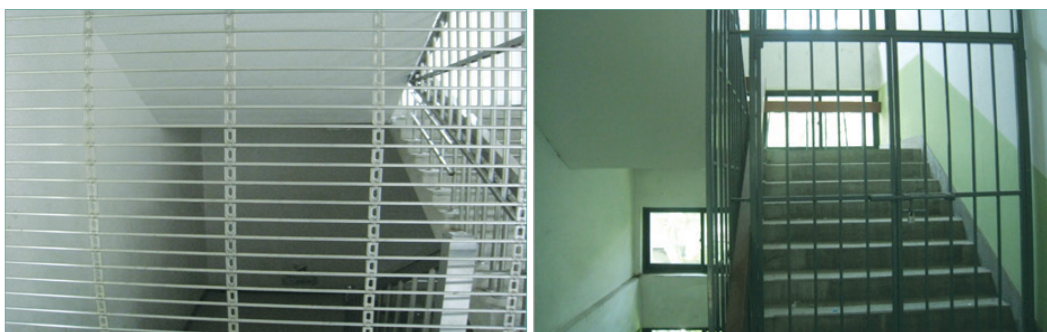
[그림 4-34] 투시형 접근통제 시설을 설치한 지하층 및 옥상 진입부
