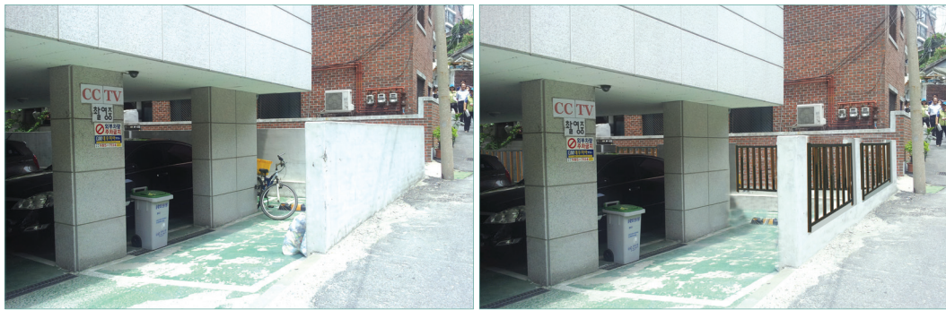
[그림 4-30] 접근통제와 자연감시를 위한 투시형 가벽 설치
