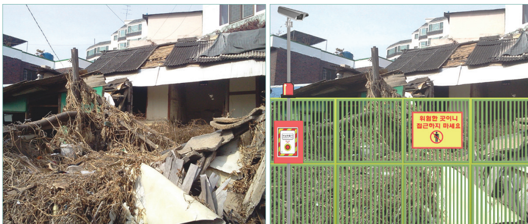
[그림 4-122] 방치된 폐가의 출입통제 시설
