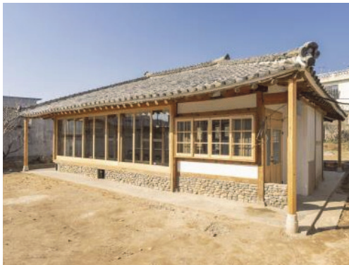
광양읍 읍내리 한옥 처마 귀퉁이 활주 보강(좌), 우물자리 확인 후 재현(우)
