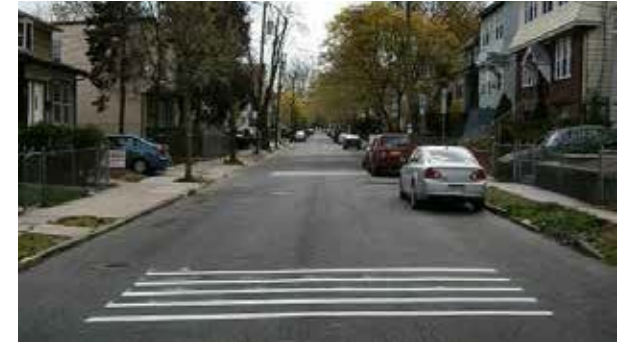
027 럼블 스트립(Rumble Strip)
