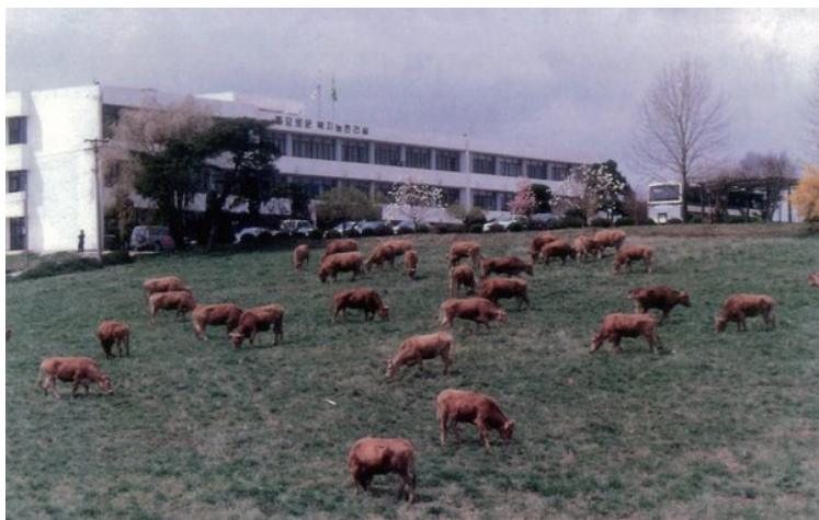
국립축산과학원이 위치했던 당시의 전경
