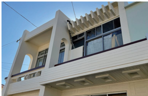
① 수직벽체와 콘크리트 루버
