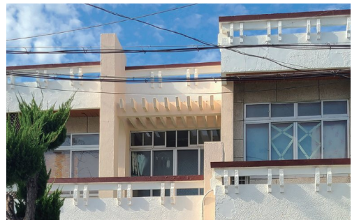
③ 콘크리트 루버
