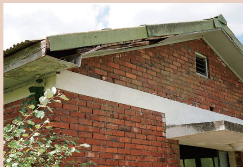
구조: 지붕 목조 트러스조+RC조
