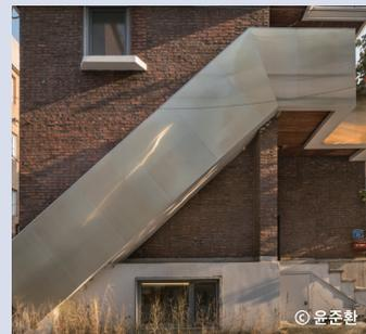
2층으로 올라가는 계단난간에 발색 스테인리스스틸 패널 설치
