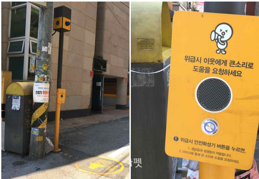
[그림 5-64] 위치정보 안내판 설치 사례 출처: 연구진 촬영.
