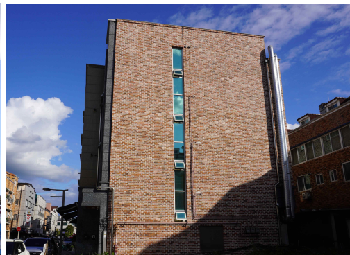
[그림 5-37] 측면 계단실 투명유리창 설치 예시 출처: 연구진 촬영.
