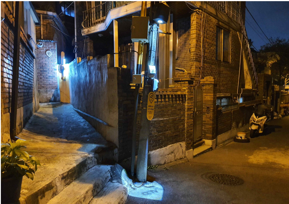
[그림 5-62] CCTV 설치 사례
