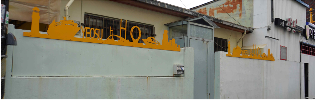
[그림 5-40] 담장 위 방범펜스 설치 사례1
