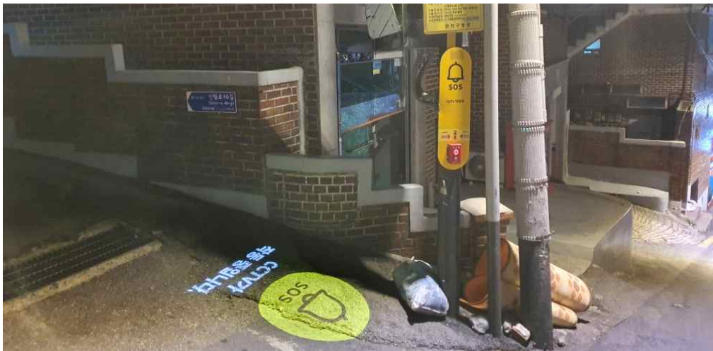
[그림 5-63] CCTV 및 비상벨 설치 사례 출처: 연구진 촬영.
