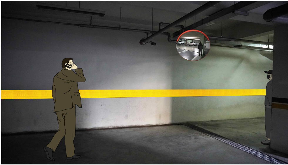
[그림 5-39] 주차장 반사경 설치 예시
