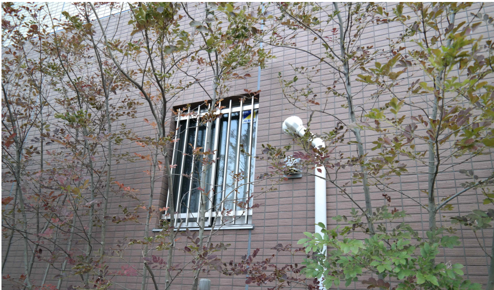
[그림 5-21] 매립형 방법창살 설치 예시
