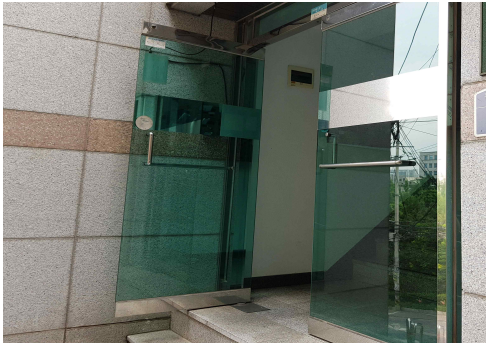
[그림 5-2] 고정형 플로어 힌지 사용 예시
