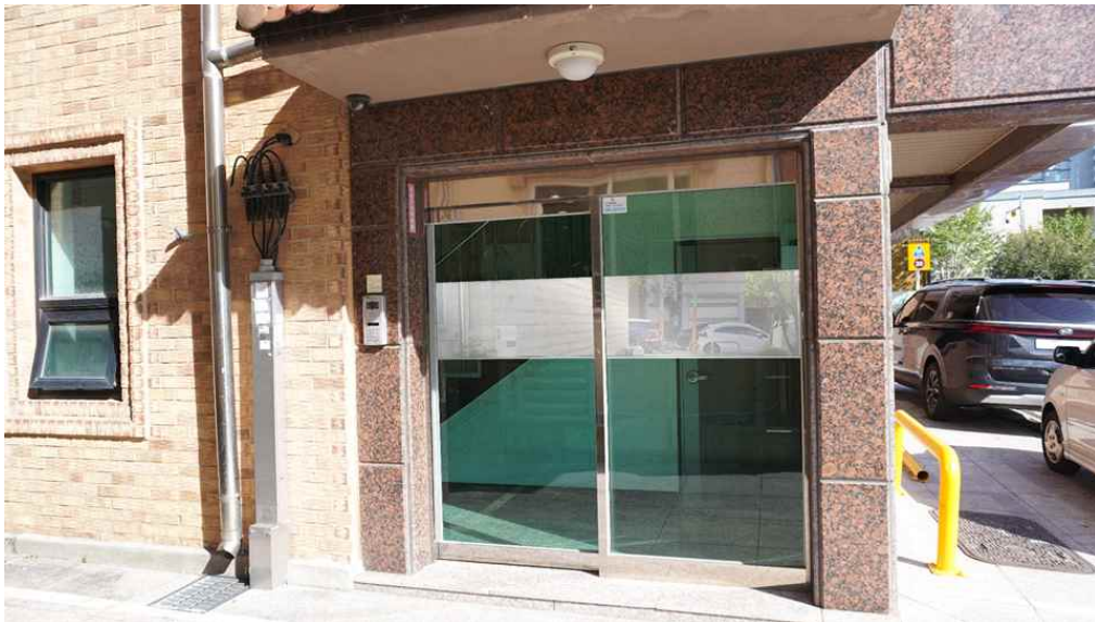
[그림 5-9] 공동현관 출입문 미러시트 설치 예시
