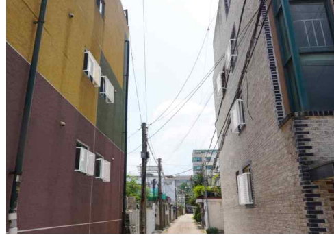
[그림 5-19] 차면시설 설치 예시
