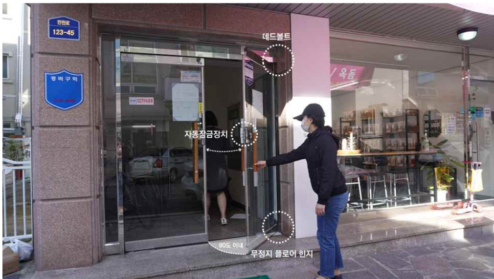
[그림 5-1] 공동현관 출입문 접근통제 예시
