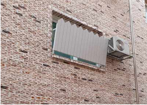
[그림 5-18] 차면시설 설치 사례
