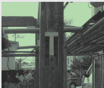
상 상촌재 안채 대청에 재사용된 기존 한옥의 대청과 종랑 중 별채에 재사용된 기존 한옥의 기둥 하 기둥을 재사용하기 위한 보강과 재치목
