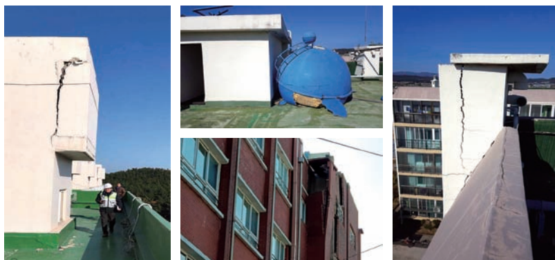
포항 지진 때 비구조재 낙하로 인한 2차 피해 가능성 사례
