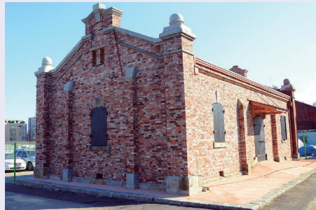
인천 내항에 위치한 옛 세관창고 전경
