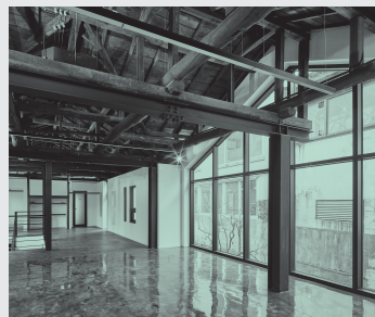
상 변경 전 회현동 앵커시설의 모습 중 위에서 내려다 본 회현동 앵커시설 하 철골로 보강한 내부
