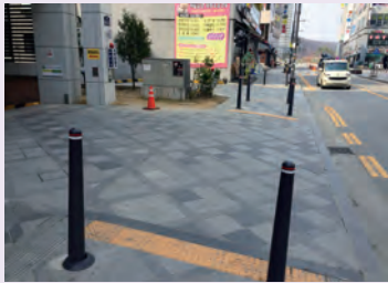
주차장 출입구 점자블록 설치를 규정하고 있는 세종시 지구단위계획 시행지침 및 설치 사례 자료: 국민권익위원회(2017), "보도 가로지르는 주차장 출입구 바닥에 '점자블록' 설치 추진된다", 7월 27일자 보도자료.
