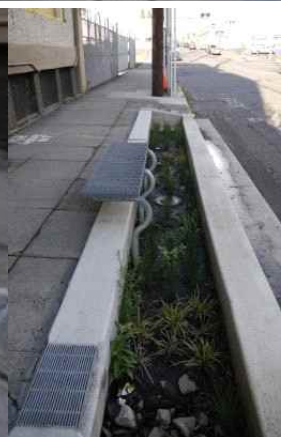
▶다양한 형태의 스톰워터 수집시설. 보도 일부공간에 식재 및 스톰워터 수집이 가능한 공간을 마련하였다. 벤치가 설치되어 있다.
