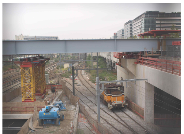
그림. Paris Seine-Rive-Gauche 내에 철도부지 위 인공지반(건설중)
