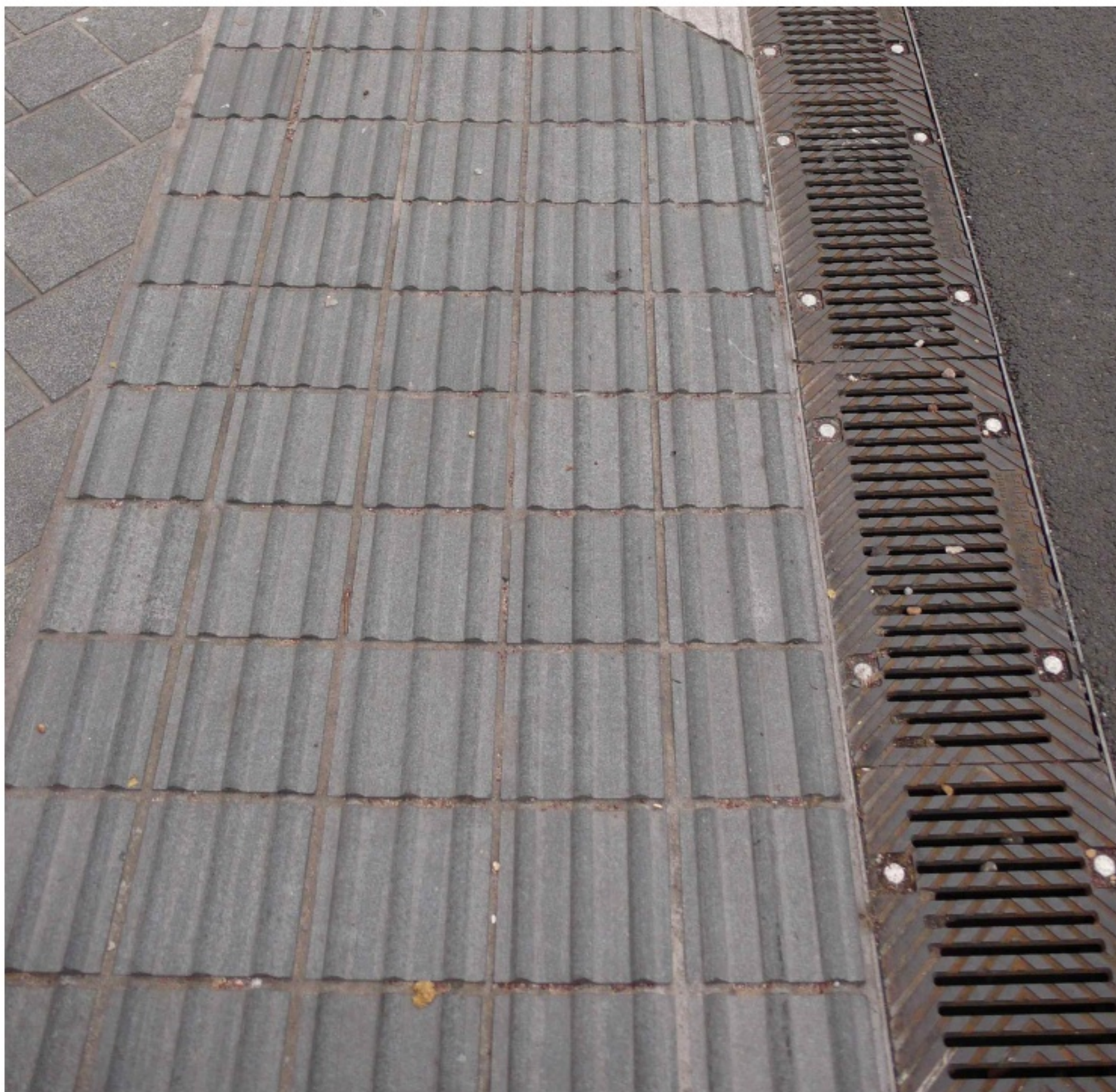
시공디테일: 시각장애인을 위한 보-차 영역 경계의 Corduroy-Textured Delineator 와 배수구
