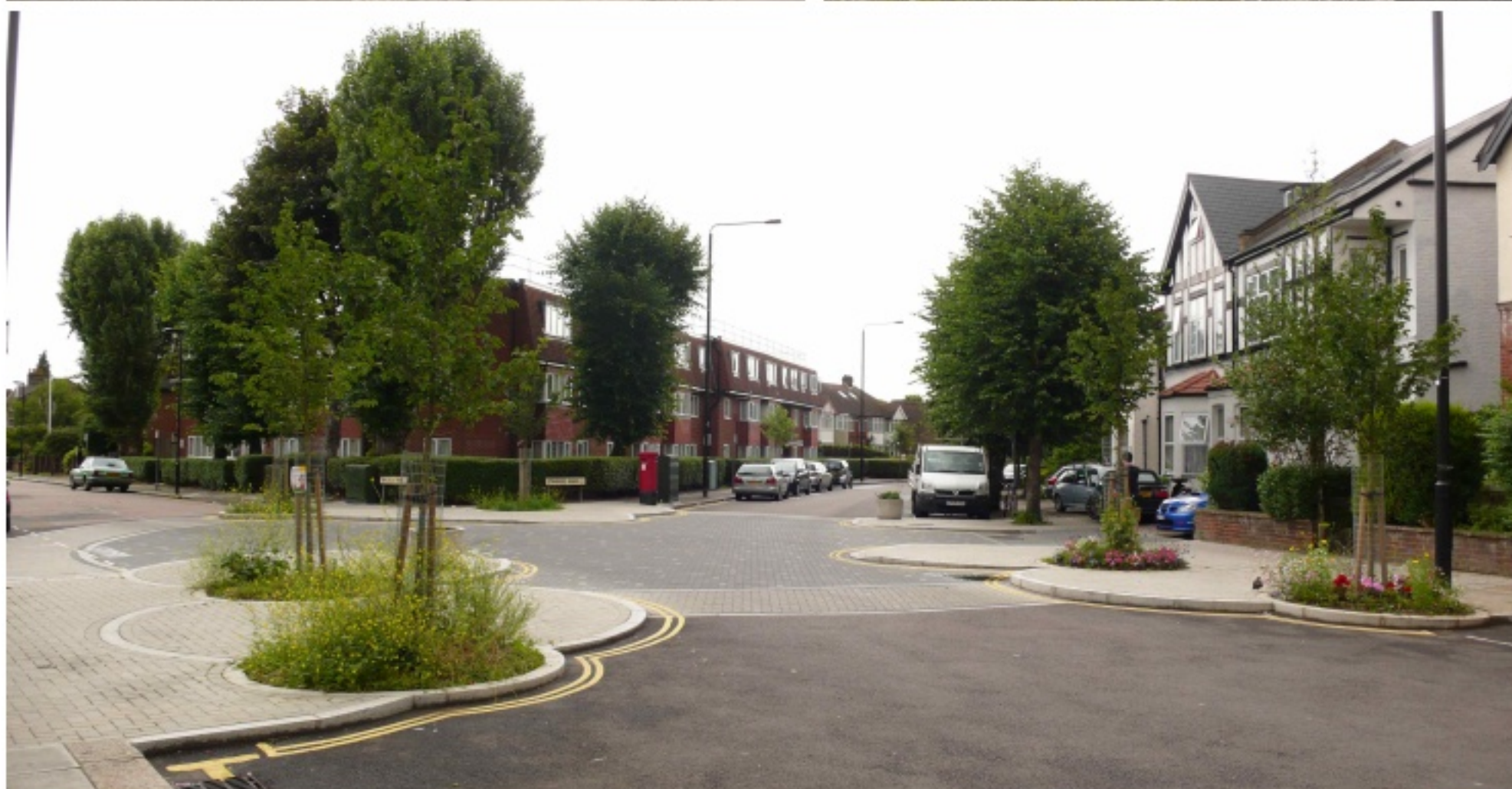
가로수와 화단이 교차로 방향으로 돌출되어 차량 흐름을 제한하고, 정원처럼 아늑한 느낌을 준다.
