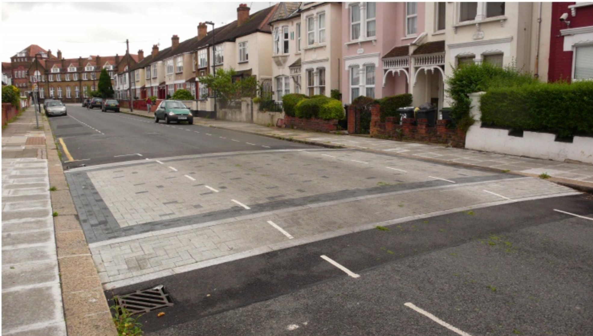
고원식 횡단보도. 도로의 구간이 길 경우, 중간 지점에 과속방지턱과 횡단보도의 역할을 겸하는 Raised Table을 설치하였다.
