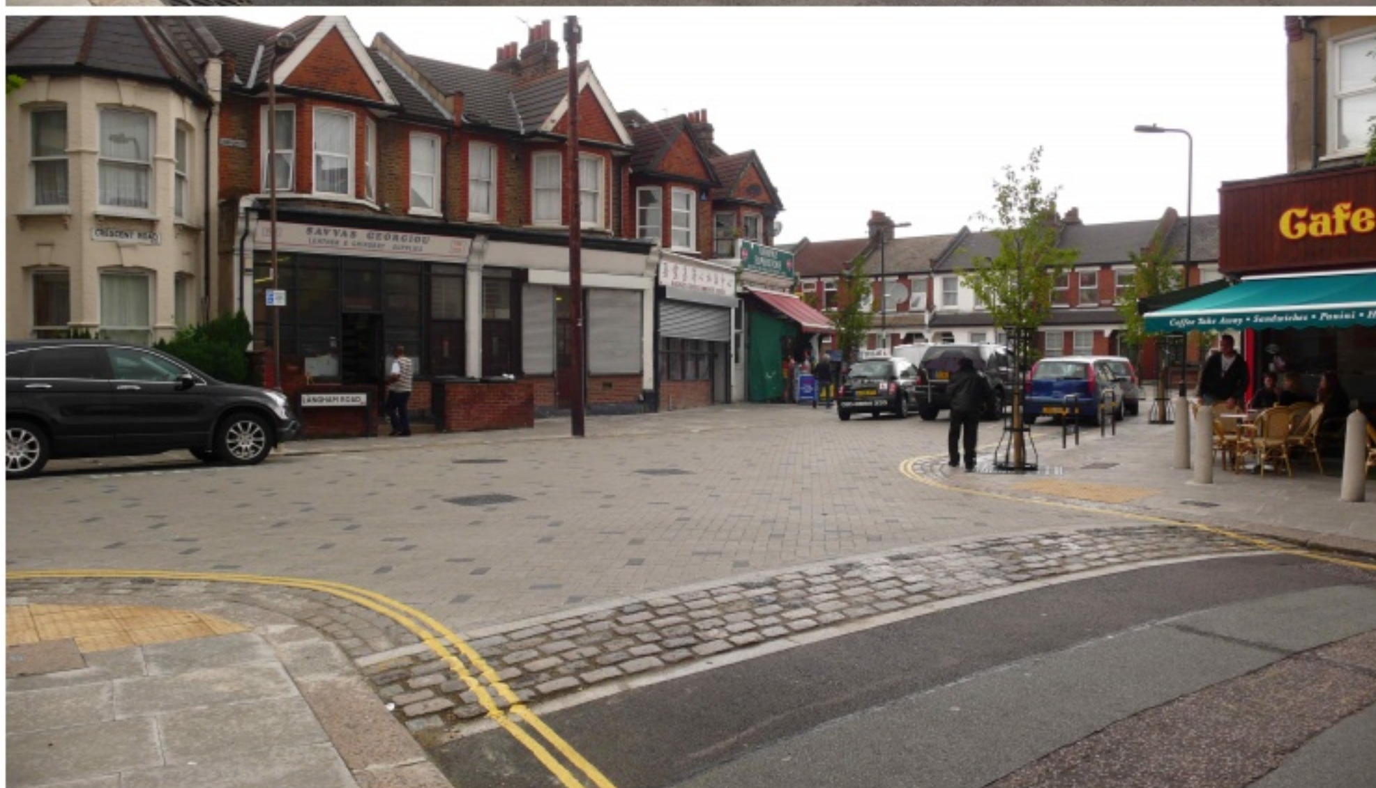
대상지 내 근린상업시설들이 모여있는 가로에는 두 개의 교차로를 연결하는 선형 구간 전체를 모두 고원식으로 처리하여 장소성을 강화하였다.
