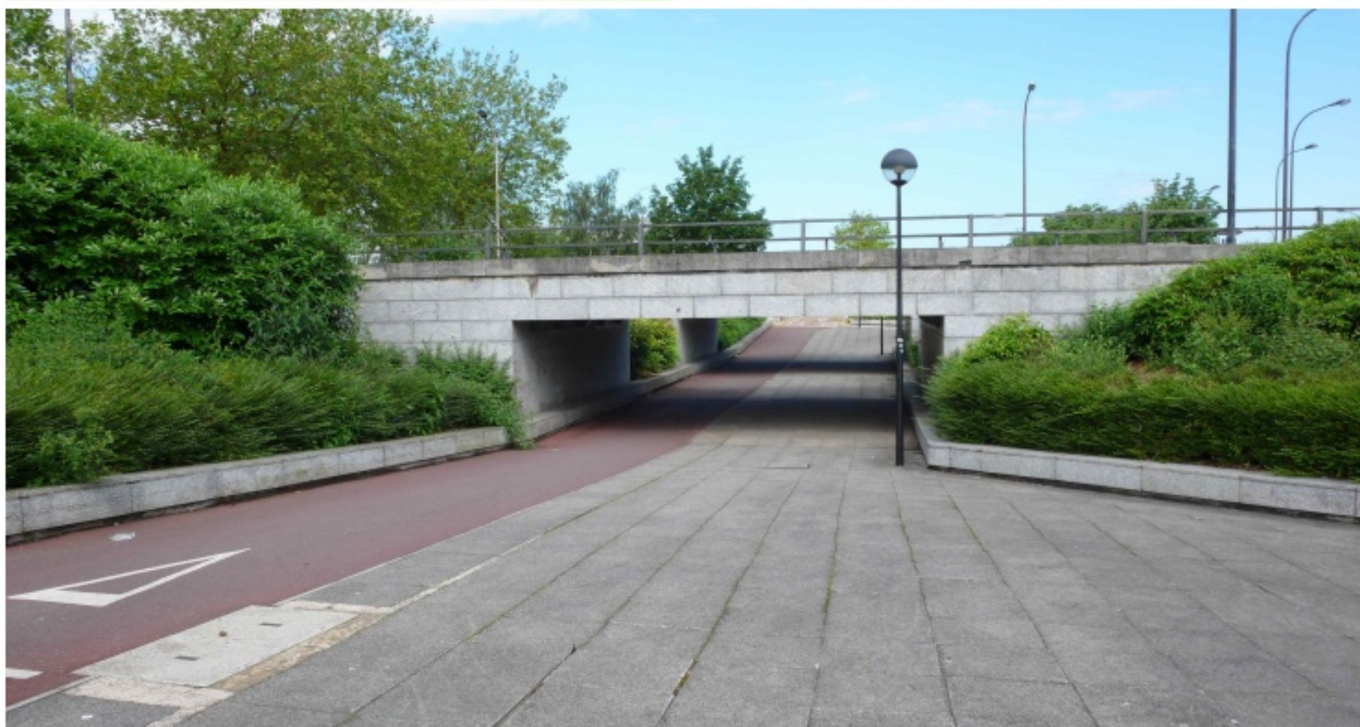
자동차와 보행자를 입체적으로 분리한 교차로. 자동차가 다니는 도로 아래로 보행로와 자전거도로가 지나간다.
