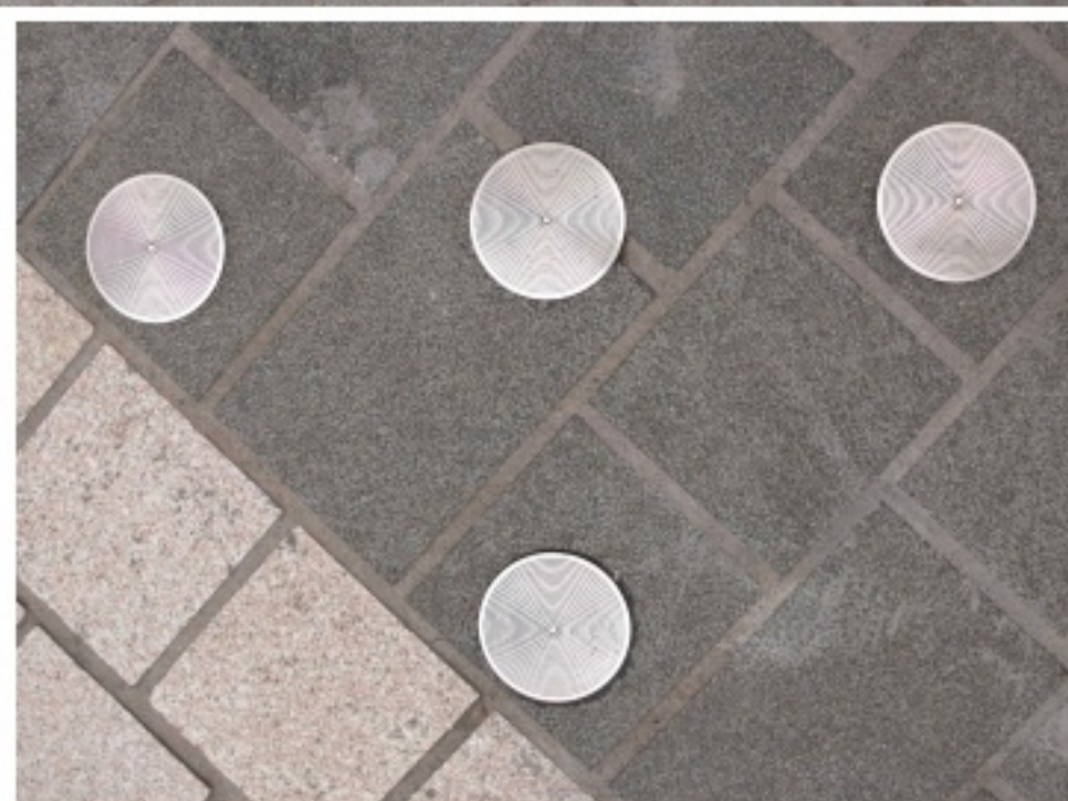
주차구획은 선을 긋지 않고 Stainless Steel 재질의 단추로 모서리만 표시하였다.
