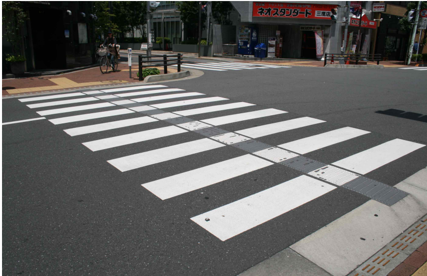
횡단보도의 중심선을 따라 연속적으로 설치된 점자블록
