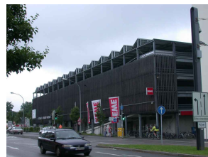
Vauban의 태양열 주차장 건물 태양판과 나무조각 및 스킴을 이용하여 온수와 65%의 전기를 지역에 공급
