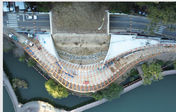
목구조공사 완료 모습
