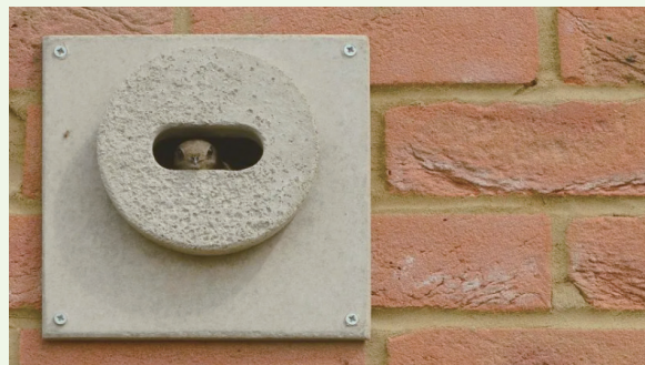
건물에 설치된 스위프트 브릭
