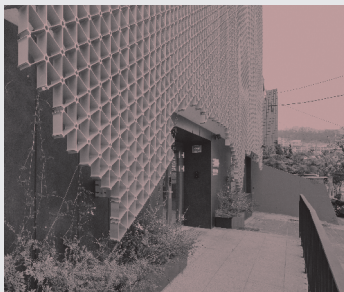
상 리모델링 후 입면 하 알루미늄 파사드
